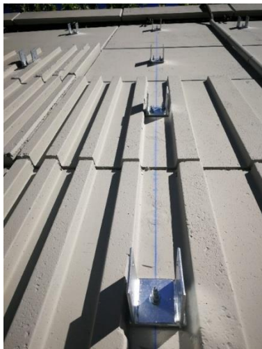
Anclaje de casquillos e instalación de Montantes
