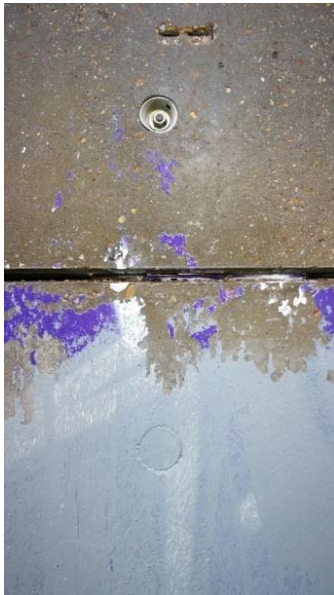
Anclajes existentes en las placas
