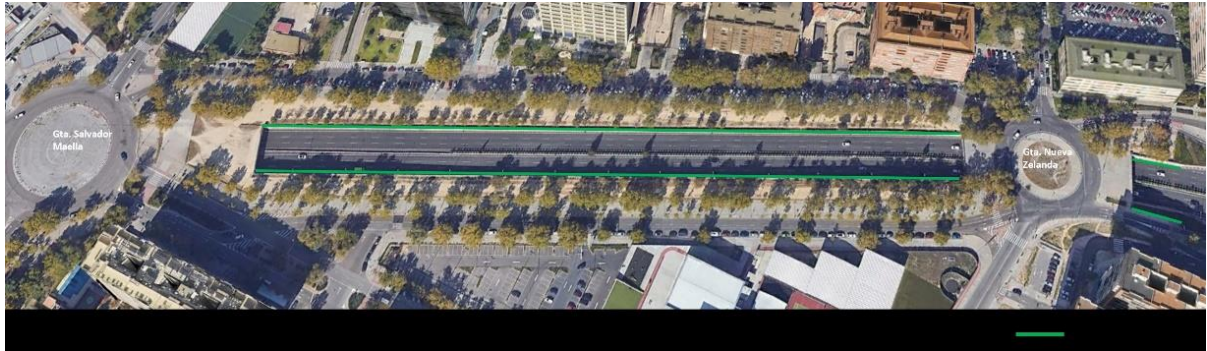
Emplazamiento actuación. Muros verticales en carretera M30 entre Glorieta Salvador Maella y Glorieta de Nueva Zelanda de Madrid
