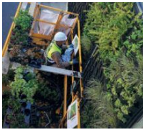
Montaje estructura y colocación plantas desde plataforma elevadora
