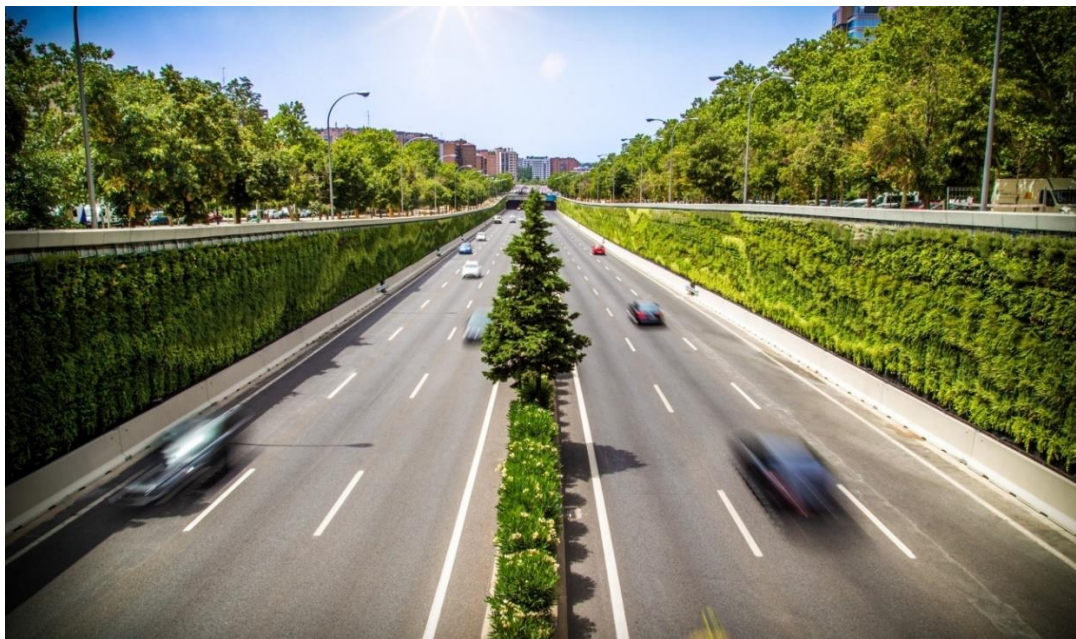
Estado final. Muros con los jardines verticales instalados
