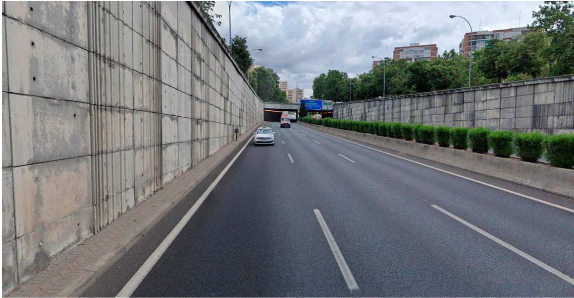
Fotografía estado previo a las obras
