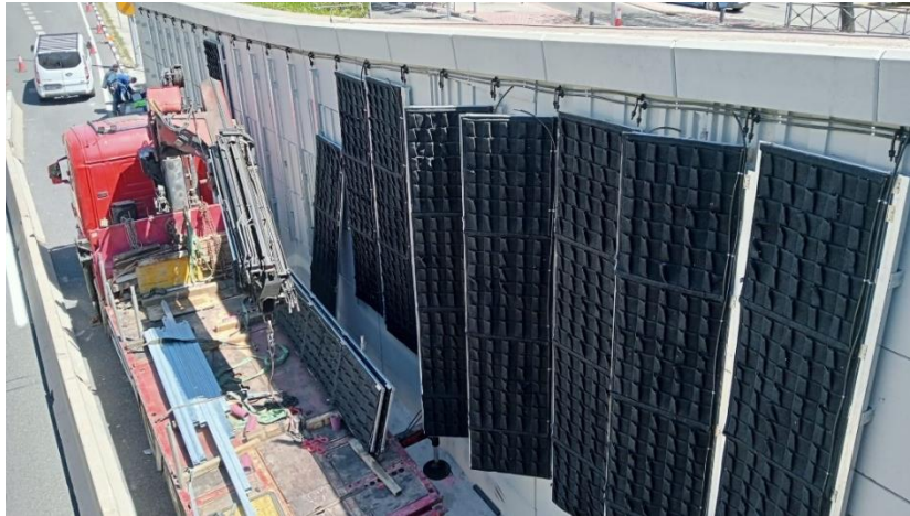
Imagen del proceso de instalación desde la vía de los paneles de jardín vertical
