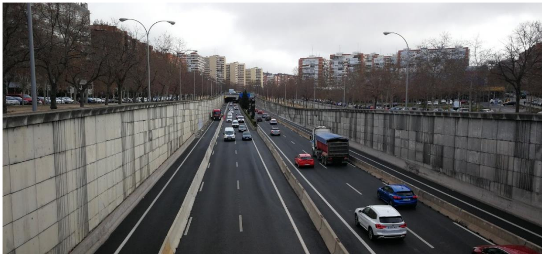
Estado previo a la actuación de los muros
