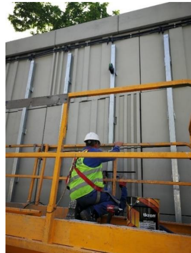
Anclaje de casquillos e instalación de Montantes
