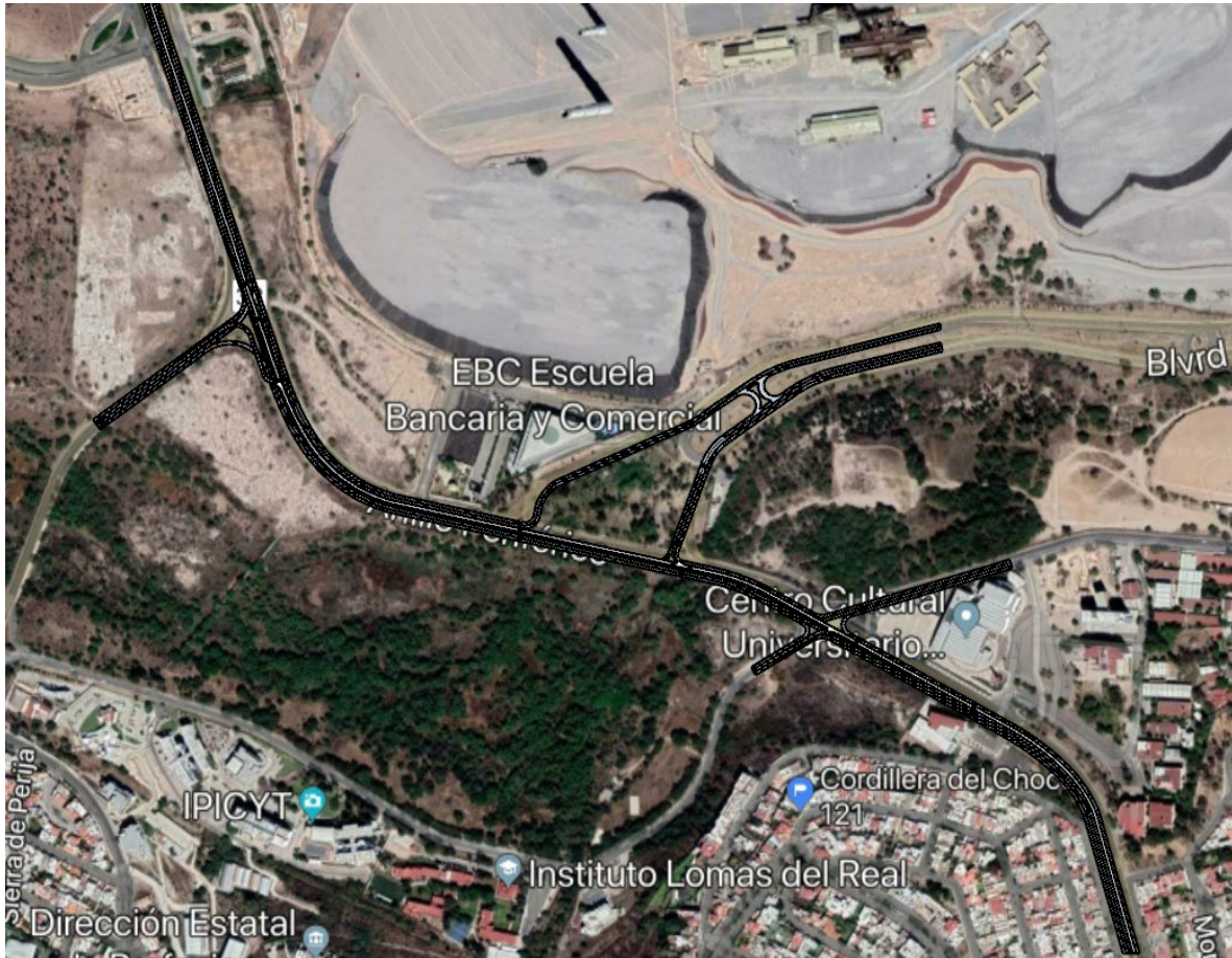
Fig. 1: Vista aérea del viaducto asimétrico
