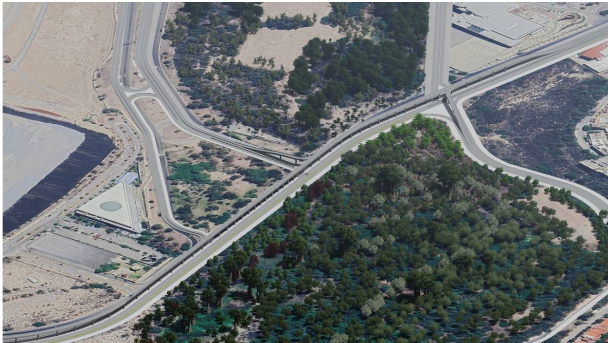
Fig. 26. Vista de la intersección del Boulevard Río Santiago con la Vía principal.
