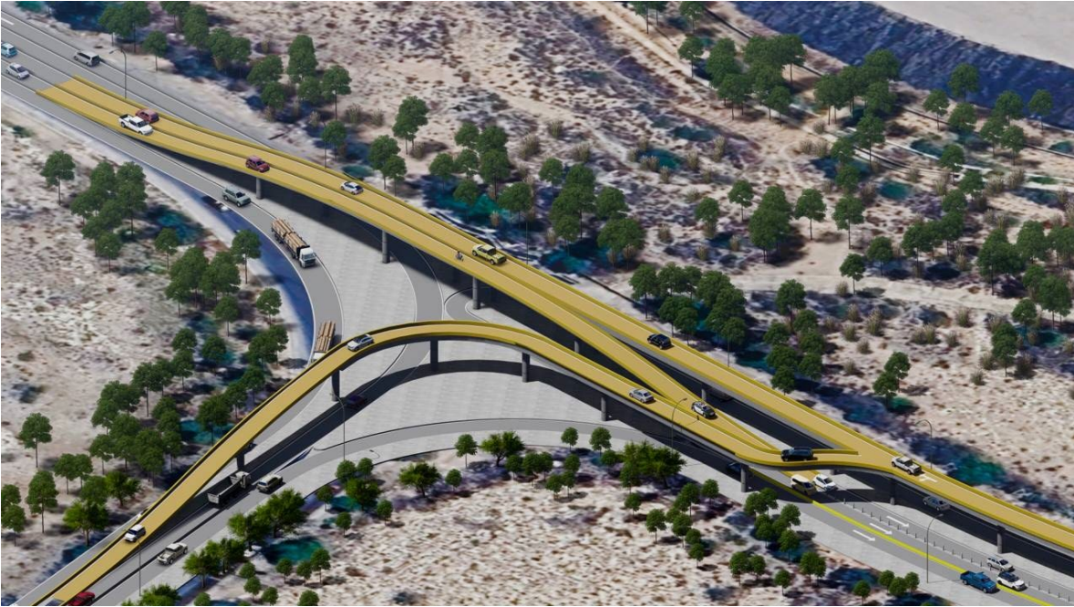
Fig. 24. Detalle de la desincorporación al Periférico Occidente y paso elevado en el sentido contrario para permitir retorno de distribución.
