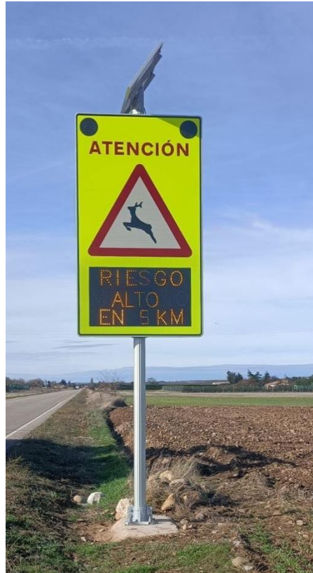
Figura 10. Modelo de señal instalado en un tramo de alta concentración de accidentes
