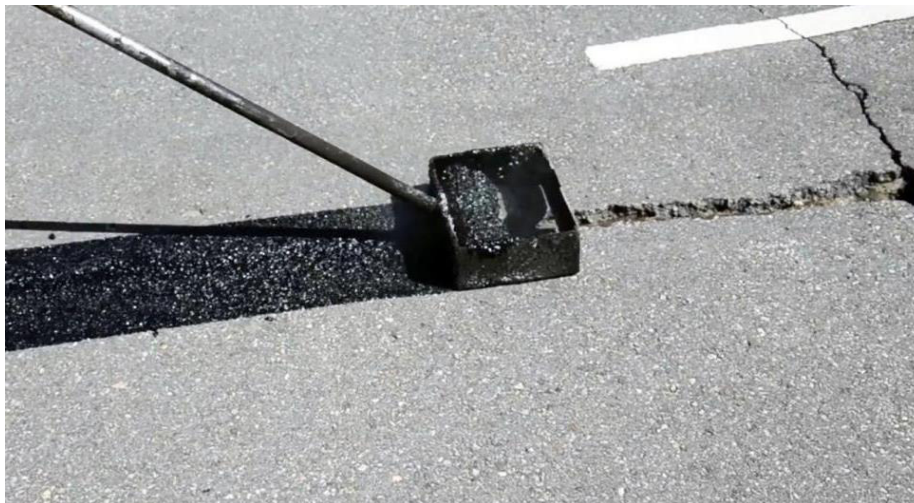
Figura 16 – Ejemplo sellado de fisuras
