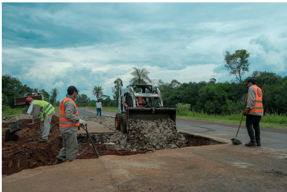
Figura 18 – Ejemplo bacheo profundo
