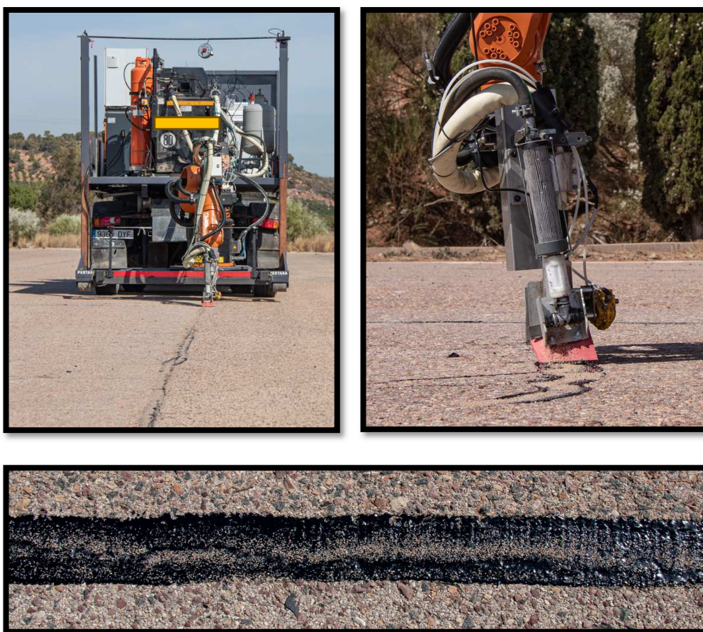
FIGURA 13. Dcha.: Sellado grieta de eje. Izq.: Sellado grietas long-trans, Abajo: Resultado de grieta sellada.
