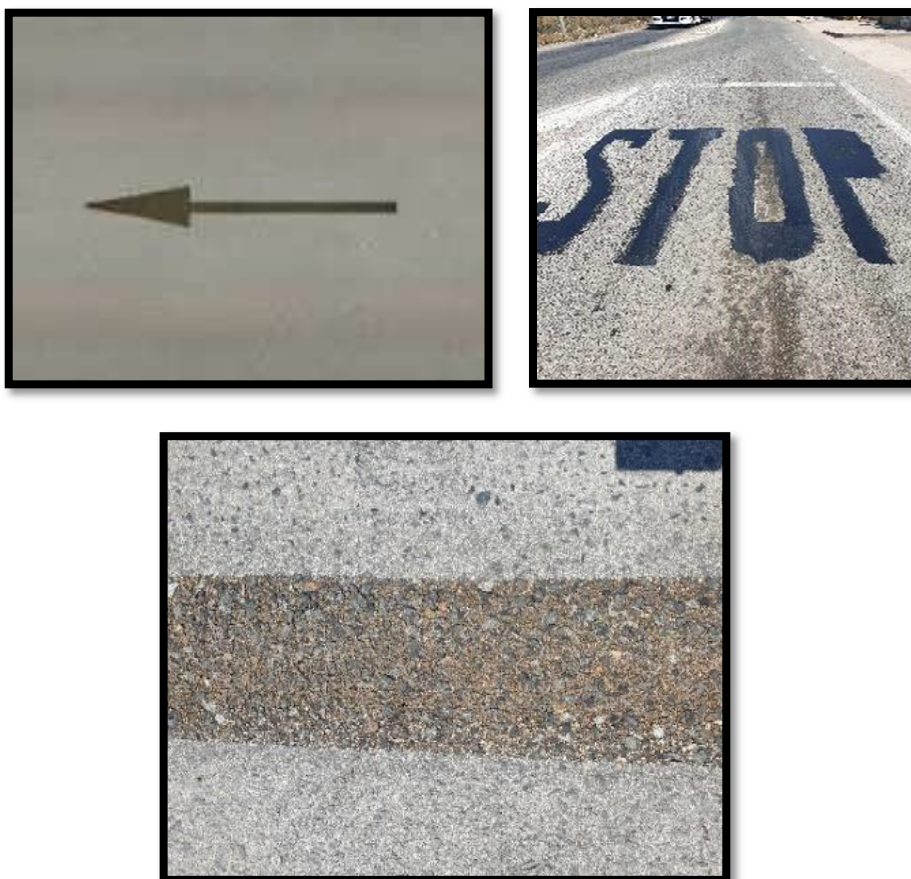
FIGURA 9. Ejemplos de señales sobrepintadas de negro y borradas con hidrolimpiadoras
