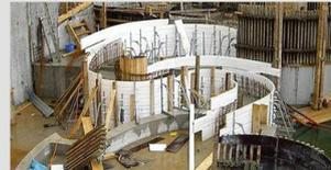
**Syflex, el encofrado flexible para muros rectos y curvos**
